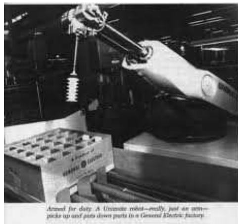
FIGURE 1.1 – Unimate, premier robot mis en place dans des chaînes de montage automobile
